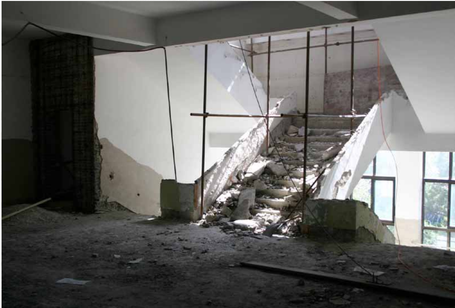
Vue du chantier mi-October 2007
