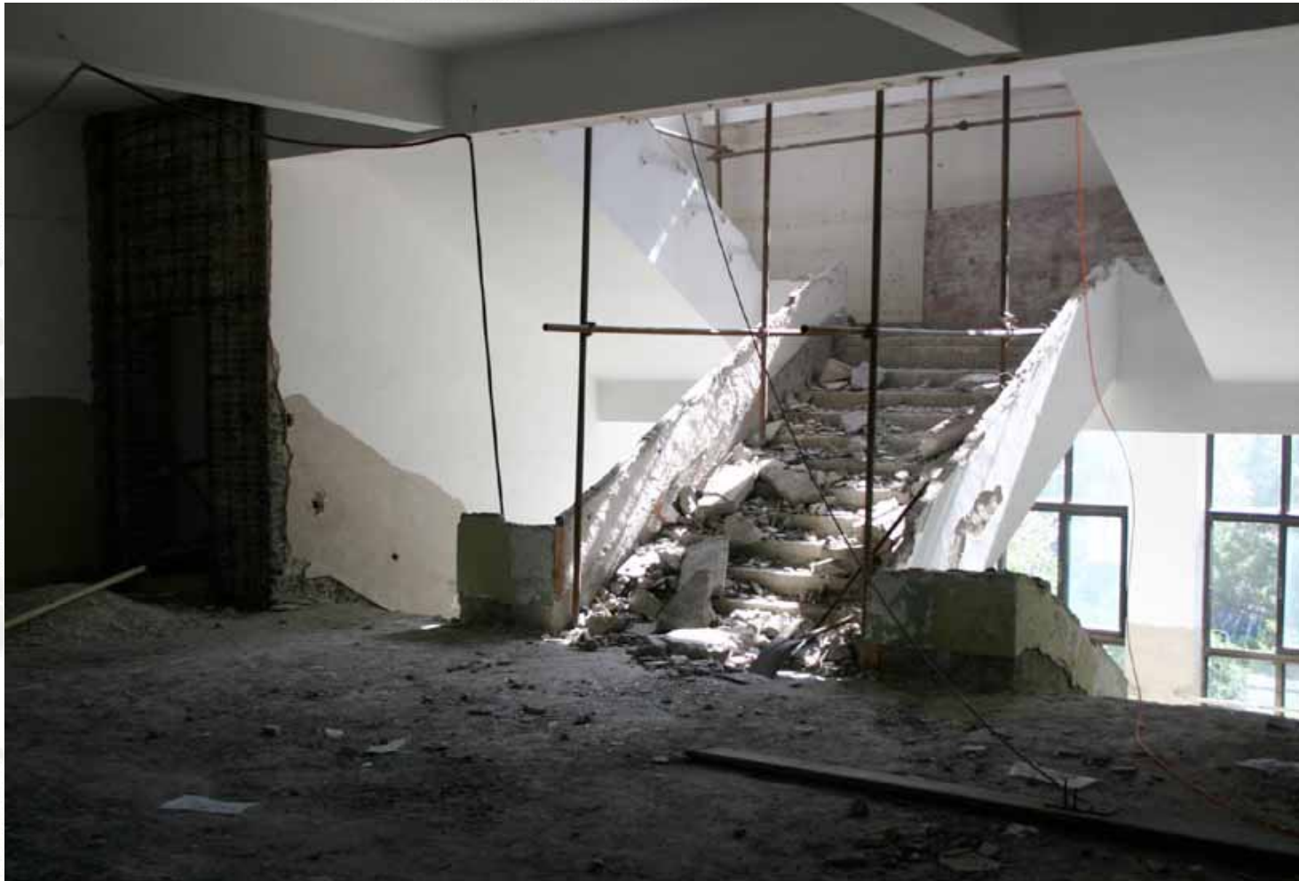
Vue du chantier mi-October 2007
